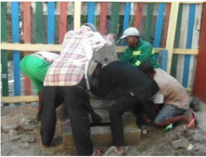
Montage de la pompe pour l'eau courante
